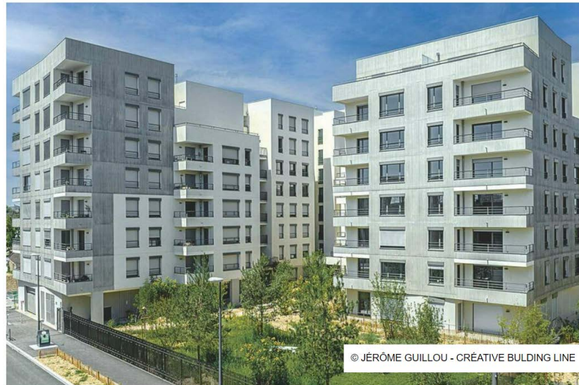
Cosmopolis propose 41 logements commercialisés en bail réel solidaire grâce à l'OFS Orsol, Ataub Arto Architectes/Arpège.
