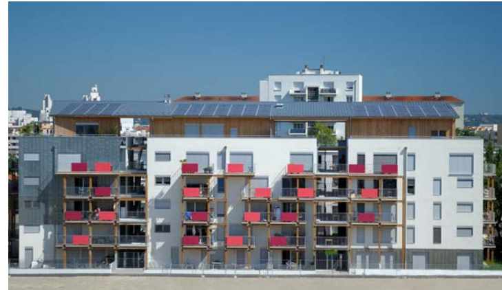
> Architectes : ARBOR&SENS et DETRY & LEVY
