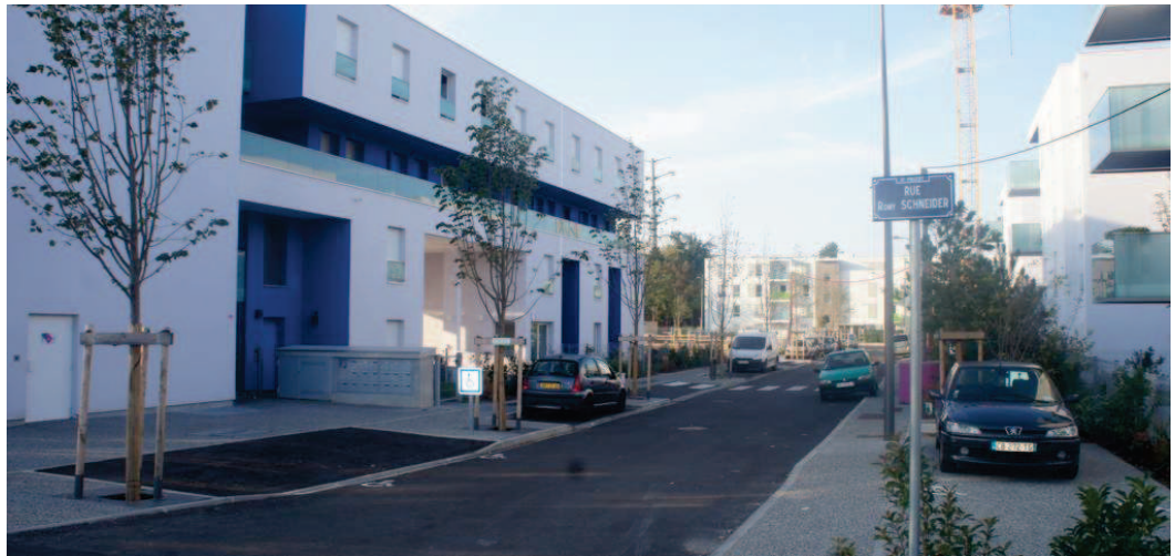
■ La création d'une nouvelle voirie a accompagné la construction des résidences Tilia et Les Tilleuls. Photo Larbi Djazouli
